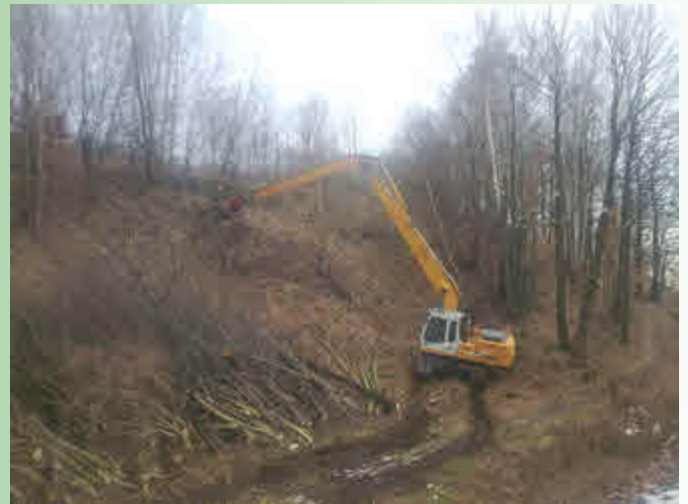
An steilen Böschungen kann der Kettenbagger seine große Reichweite ausnutzen.
