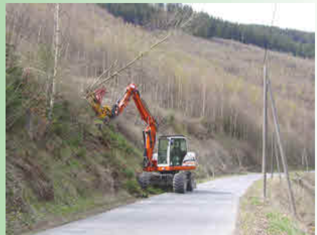
Hier schneidet ein Radbagger (11to.) Energieholz. Einsatzort: Neubau der Trinkwassertalsperre "Leibis-Lichte" in Thüringen
