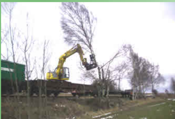
Spezialeinsatz unserer Baumschere an der Bahnstrecke der WISMUT GmbH in Ronneburg 2010: Der Bagger schneidet vom Waggon aus Randbäume
